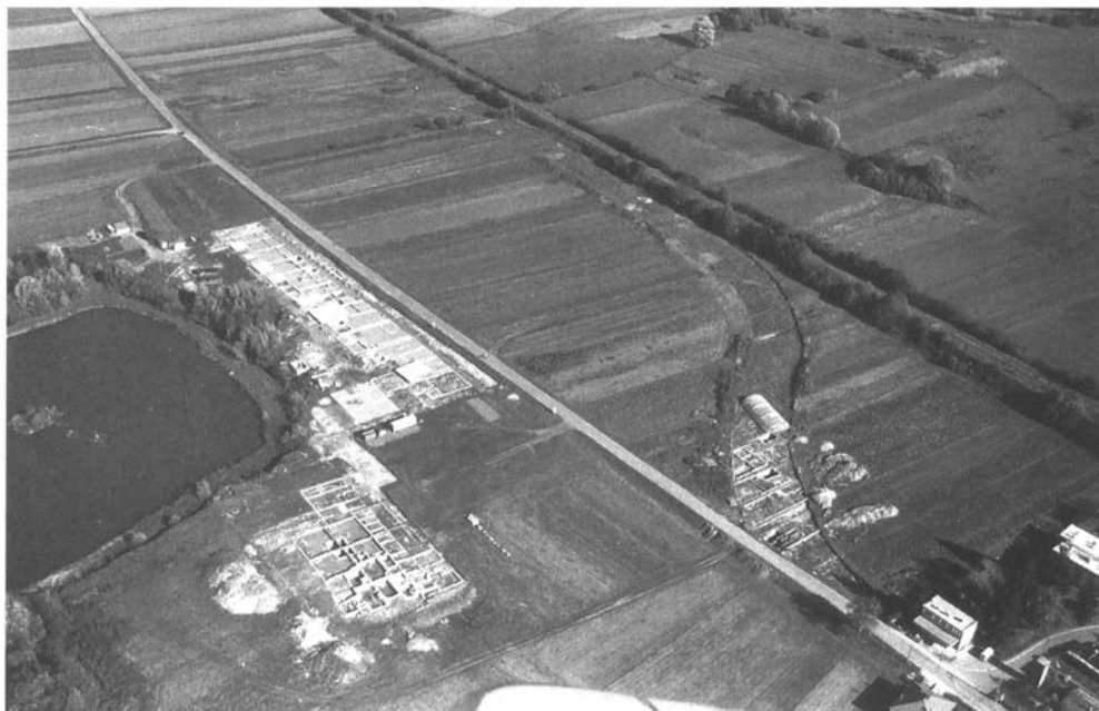
Fig. 1 : Vue aérienne du site
