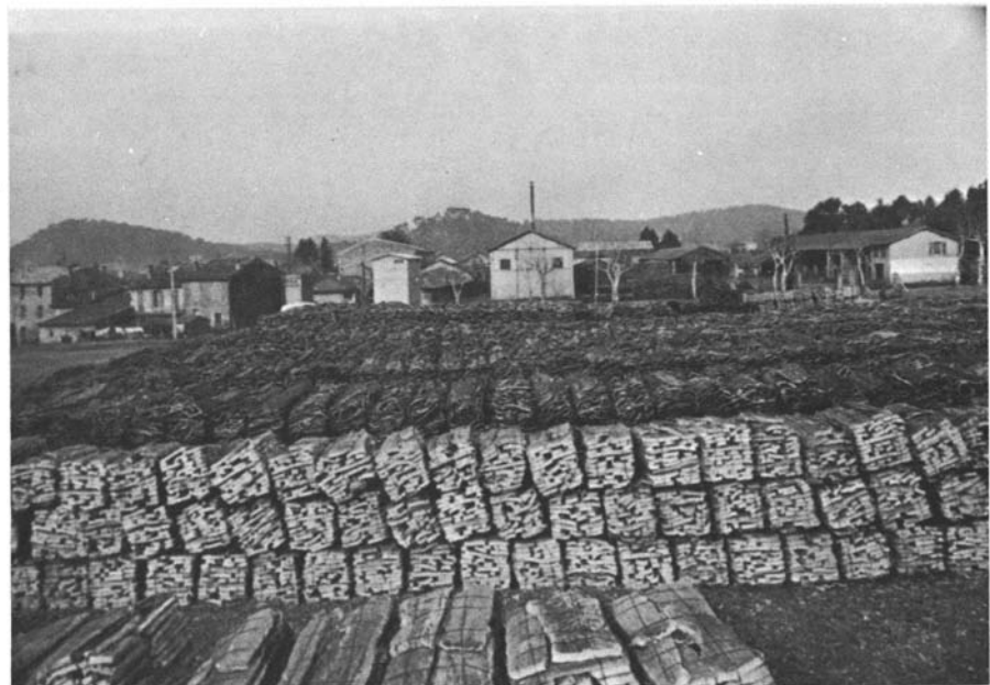
Photo 1. – Le dépôt d'une usine à Vidauban (Var) à l'époque où l'industrie du liège était active.
