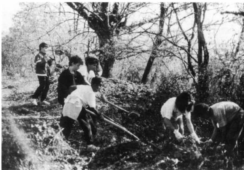
Photo 14 : Chantier de jeunes
