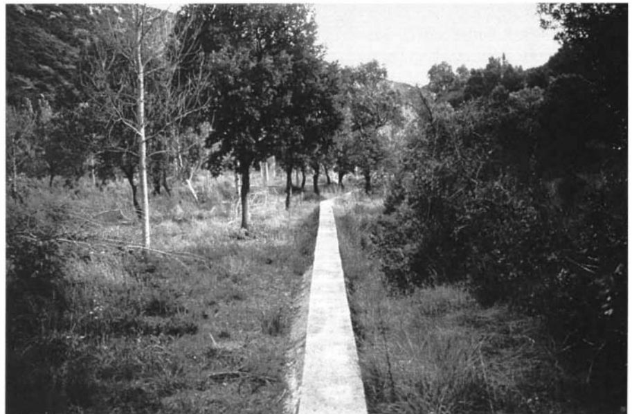
Photo 4 : Canalisation maçonnée de distribution des eaux usées épurées sur parcelle forestière (Chêne vert et peuplier) à St Jean de Bueges (34).
