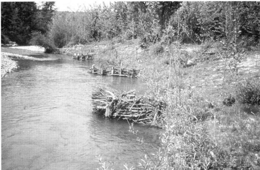
Photo 2 : Une palette de techniques végétales est à la disposition de l'aménageur pour assurer la protection des berges
