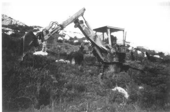
Photo 7 : La pelle-araignée en train de travailler. Photo S. Giroux
