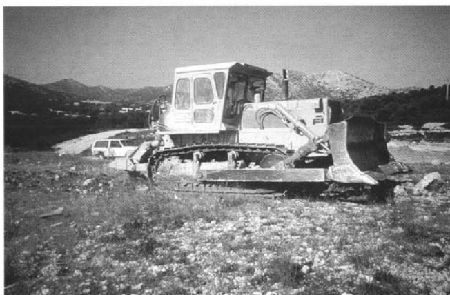
Photo 1 : Technique du sous-solage.
