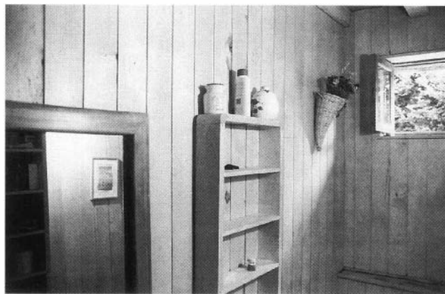
Photo 3: Menuiserie intérieure et ameublement (salle de bains), lambris, étagères. Photo C.B.
