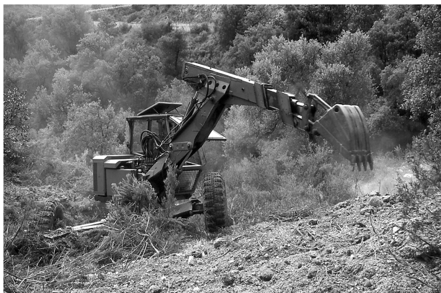
Photo 3 : Travaux réalisés à la pelle araignée
