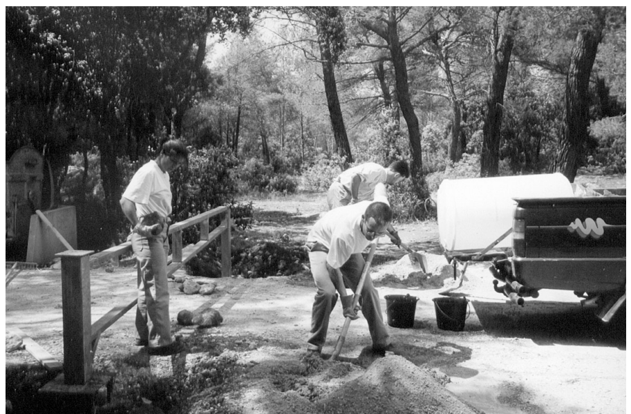
Photo 2 : Mise en place d'une barrière DFCI
