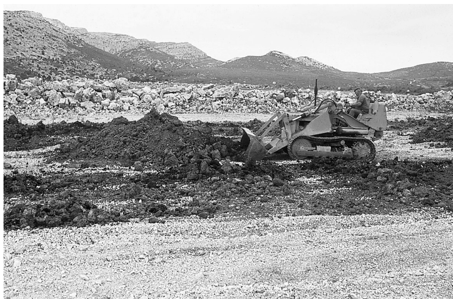
Photo 2 : Epandage des boues après préparation du terrain (sous-solage croisé, ratissage des gros blocs et constitution d'andains, concassage des pierres restantes au sol)
