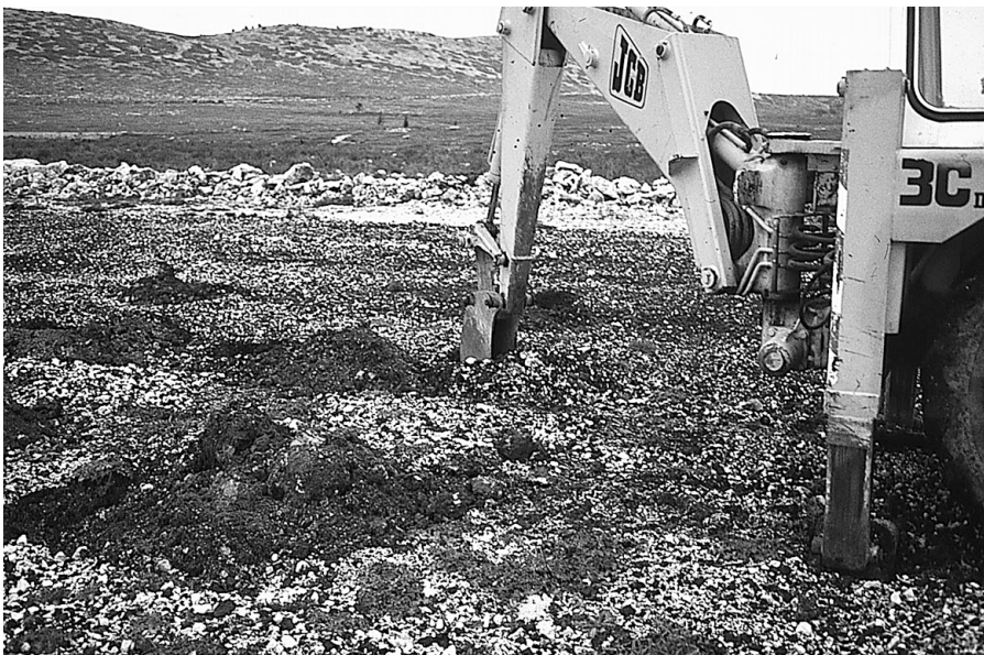
Photo 3 : Terrain prêt à la plantation après incorporation des boues dans l'horizon superficiel du sol.
