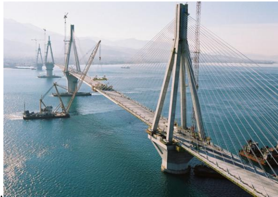
Figure 7 : Construction du tablier
