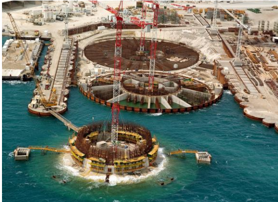
Figure 6 : Construction des embases de fondation
