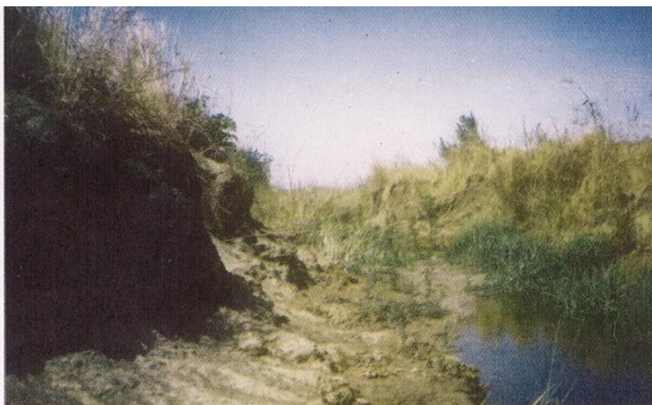
Photo 3 : dans la section III, une importante ravine liée à la présence d'un ouvrage routier menace l'activité agricole dans la section II (par drainage de la nappe et par érosion régressive) (photo J. FOURNIER, déc. 1995).
