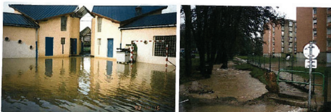
Inondation du gymnase COSEC de Ferney-Voltaire le 15 novembre 1993
