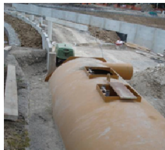
Figure 11 : Pré bassin enterré
