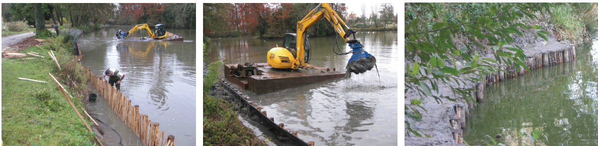
Figure 6 : bassin de Bourran – mise en place d'un clayonnage puis remblaiement des berges par les sédiments pris dans le plan d'eau
