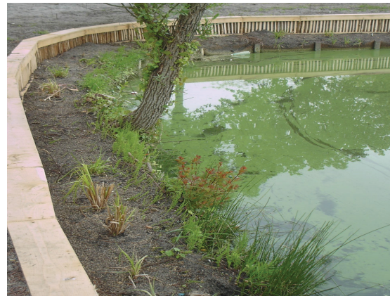
Figure 5 : bassin de Chambéry – travaux terminés, végétalisation de la terrasse inférieure
