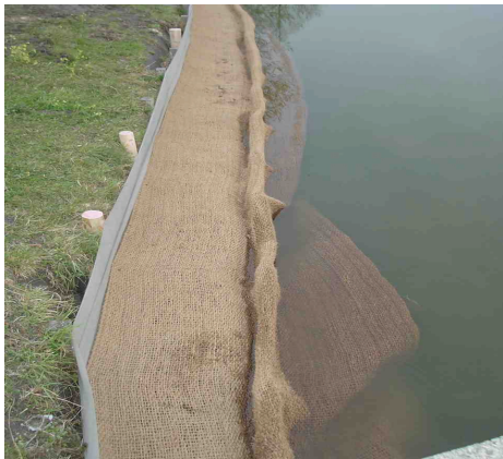
Figure 4 : bassin de Chambéry – pose de la natte en coco entre les 2 terrasses
