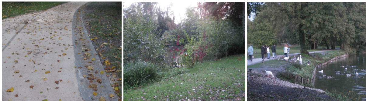
Figure 7 : bassin de Bourran – de gauche à droite, canalisation des eaux de ruissellement, plantation en herbacés et arbustes et création d'une zone d'accès au plan d'eau
