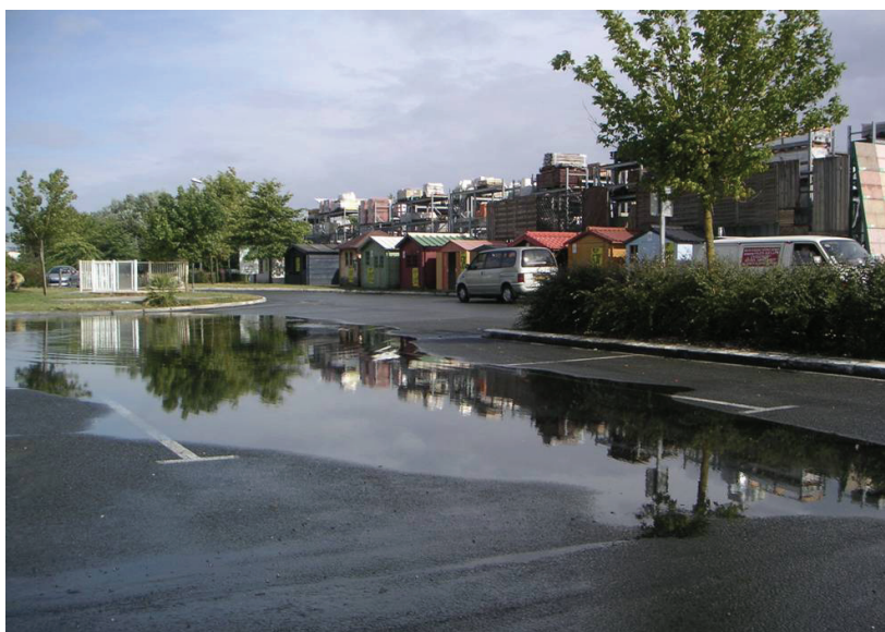
Figure 3 Un enrobé poreux après une quinzaine d'années sans entretien
