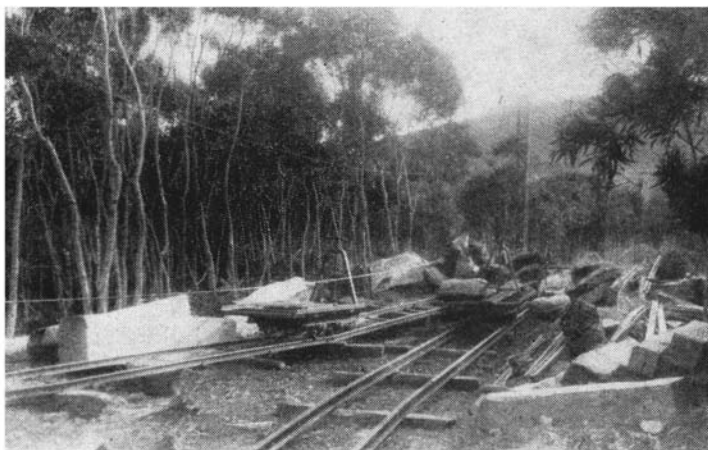
La station de déchargement du Lasso.
