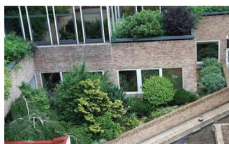
Figure 2 : Toiture terrasse jardin (intensive) sur le bâtiment de la Direction de l'eau du Conseil Général 92 (source : CG 92)
