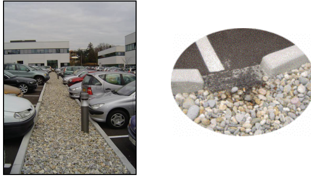
Fig. 3 : Rivière sèche - Détail de l'alimentation superficielle.
