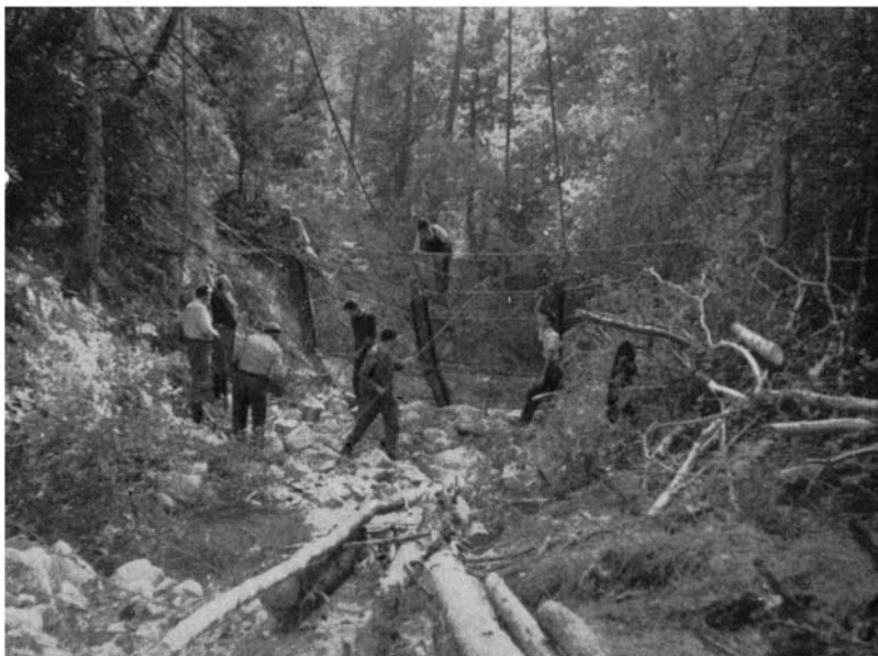
FIG. 1. Construction d'un barrage perméable dans le torrent de Bouriane (forêt de Durbon). 1955.
