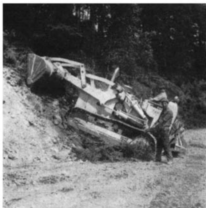
Un traxcavator occupé à la finition d'un talus.
