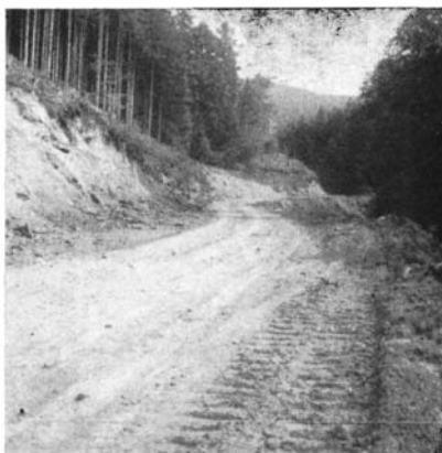
Terrassement terminé. Forêt d'Abreschviller).
