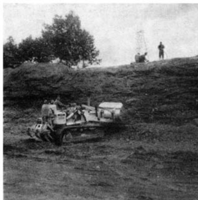
Traxcavator attaquant le front de taille.
