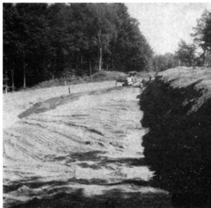
Vue d'ensemble de la carrière de Saint-Quirin. On voit les deux plans d'extraction. Déblaiement d'un coup de mine.
