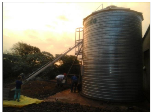
Silos. Tareas de descarga y acopiamiento de maíz
