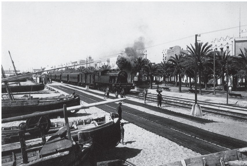
Imatge 7: Rambla de Badalona amb el tren de Costa vers 1930 (Libro de Oro de la MZA, F. Ribera). No hi ha barreres però el tren no altera l'activitat de la gent. Es poden veure els pilars amb carrils simètrics reaprofitats per conduir els dos cables de la primera instal·lació elèctrica, cada 40 metres pel costat mar per a les estacions. Encara es conserven les bases d'aquest pals amb els carrils talats en alguns trams.
