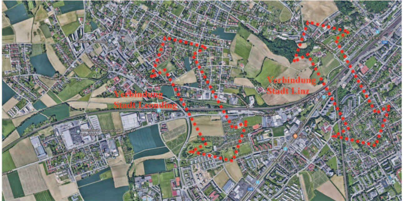
Fig. 3: Bebauung im Raum Leonding und Betrachtungsraum (Luftbild); (Google Maps, online am 09.01.2018)
