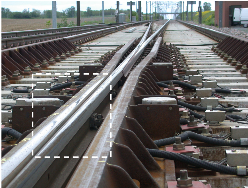
FIG. 5 – Pointe mobile . La zone de transition pointe-patte de lièvre est encadrée.
