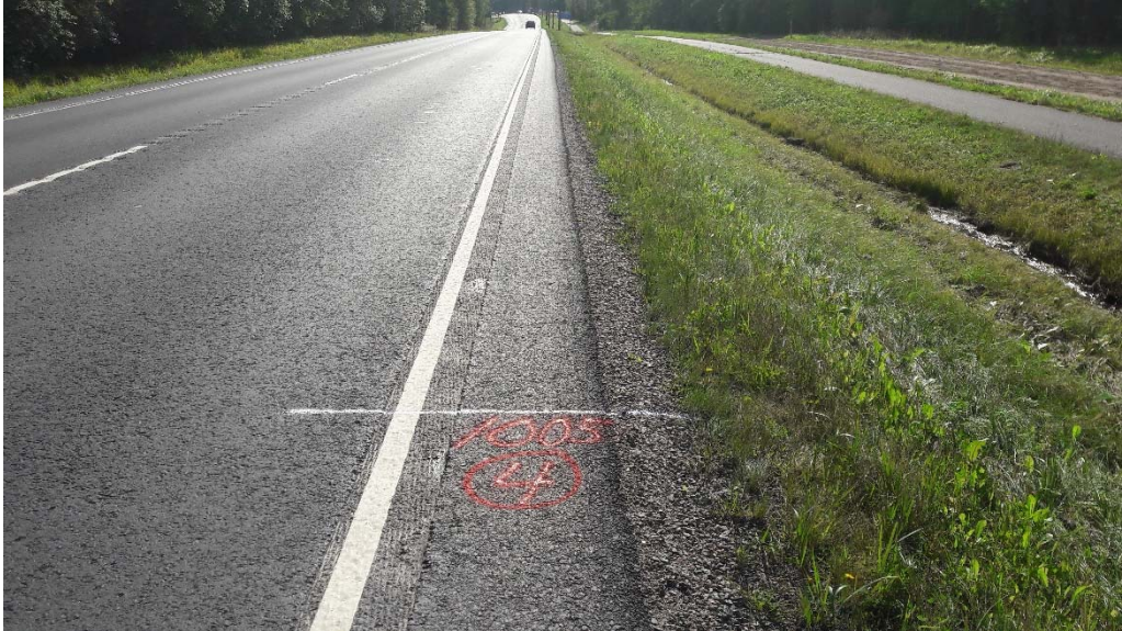
Kuva 10. Kohteet merkittiin maastoon maalimerkinnöillä.
