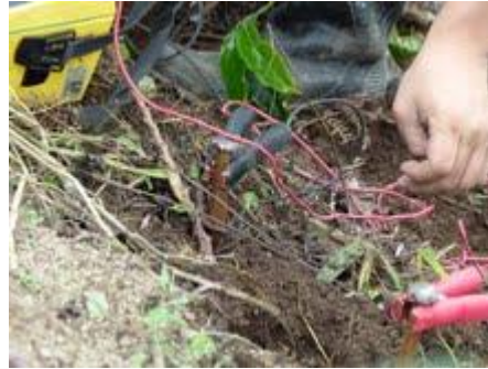
Figura 11. Instalación de electrodos para toma de medida.
