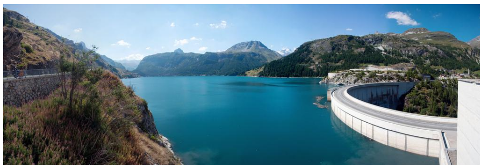
FIGURE 1.2 – Barrage de Chevril, aussi appelé barrage de Tignes, installé sur le cours d'eau de l'Isère (Savoie).
