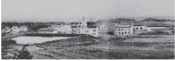
写真5 完成直後の関西学院と神呪池
