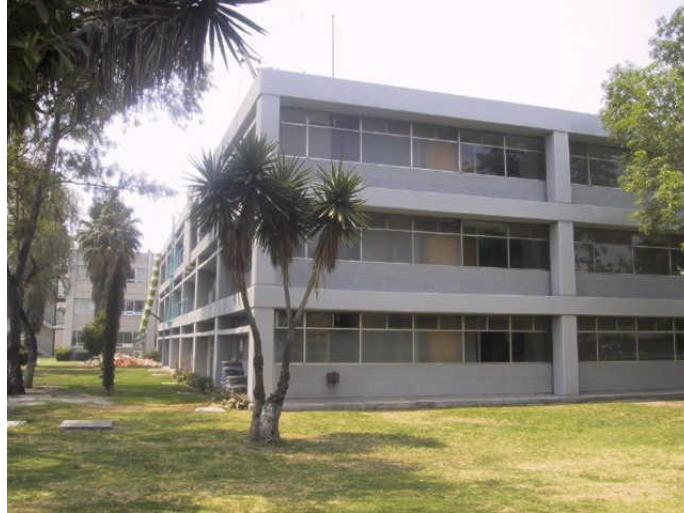
Fotografía 13. Vista exterior del Edificio R.
