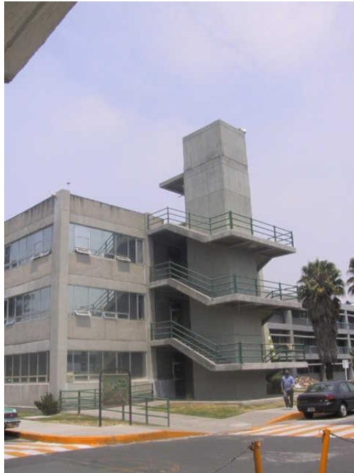
Fotografía 4.- Vista Lateral del Edificio AS
