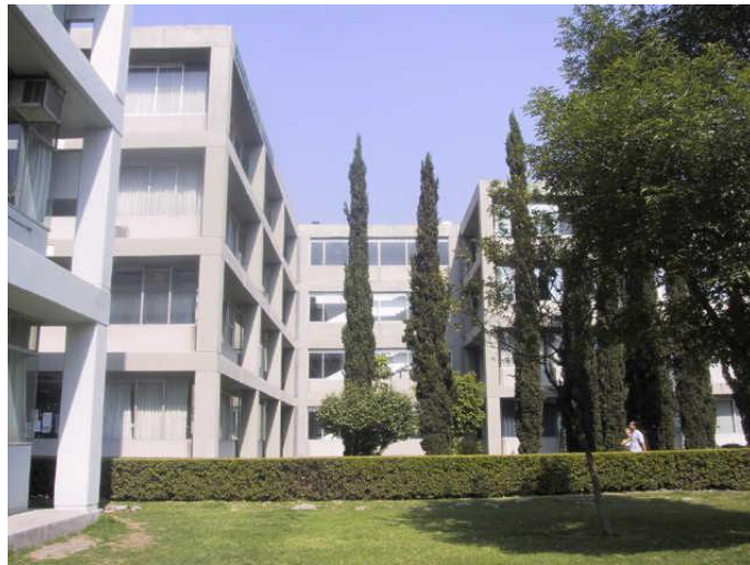
Fotografía 13. Vista exterior del Edificio T.
