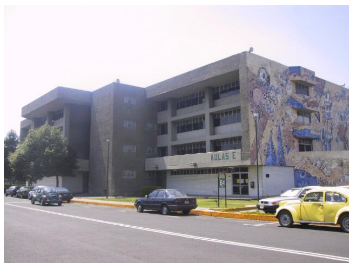
Fotografía 9. Vista exterior del Edificio E.
