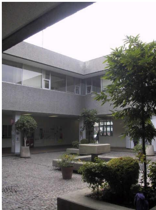
Fotografía 1.- Vista Frontal e Interior del Edificio A
