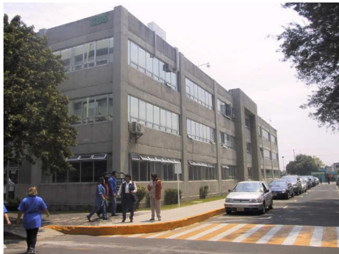
Fotografía 3.- Vista Posterior del Edificio AS
