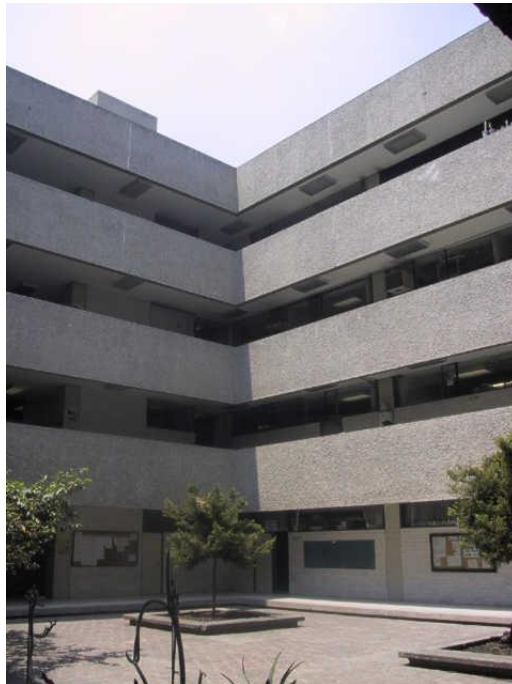
Fotografía 13. Vista interior del Edificio S.
