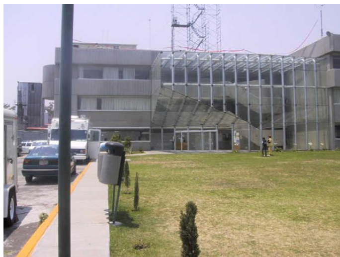
Fotografía 14. Vista exterior del Edificio W.
