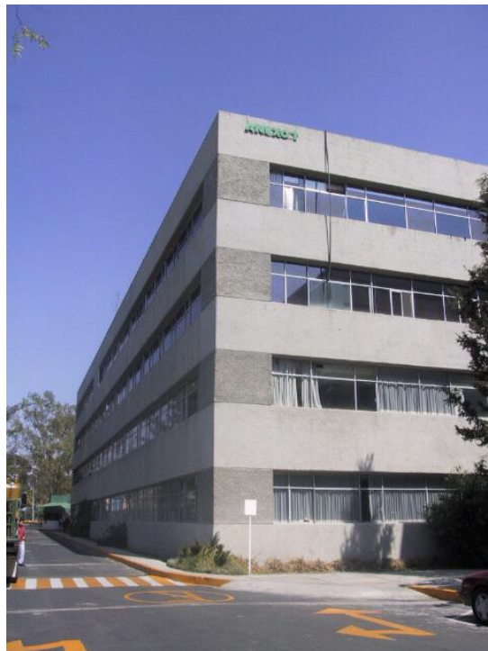
Fotografía 5.- Vista del Edificio AT
