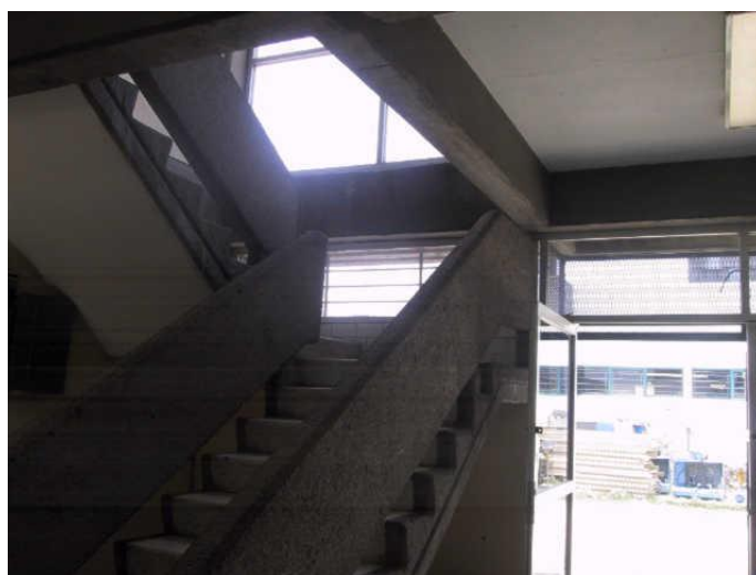
Fotografía 12. Vista exterior e interior del Edificio Q1
