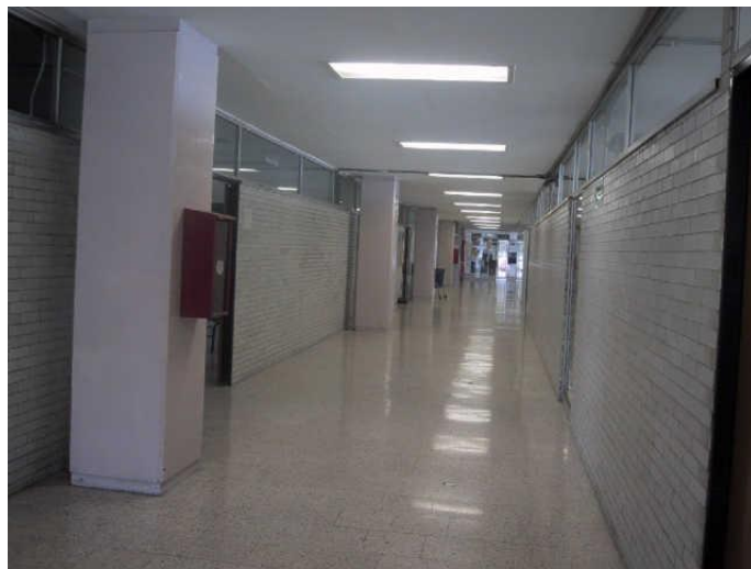
Fotografía 8. Vista exterior e interior del Edificio D.
