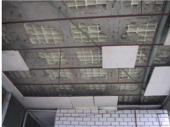
Fotografía 2.- Losa del Edificio A
