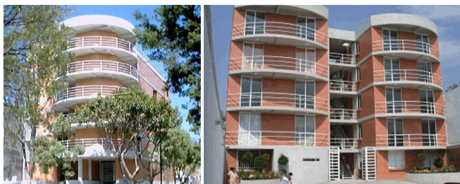
Figura 2.7. Estructuras modernas de mampostería (D.F., México).
