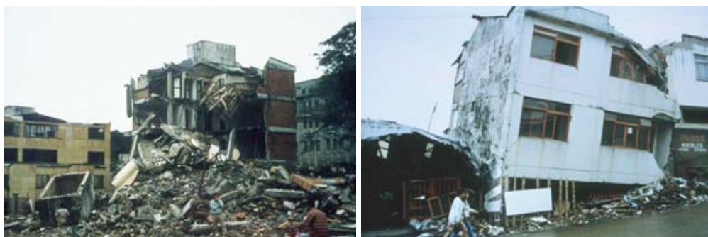
Figura 2.6. Estructuras de mampostería después de un sismo (Armenia, Colombia).
