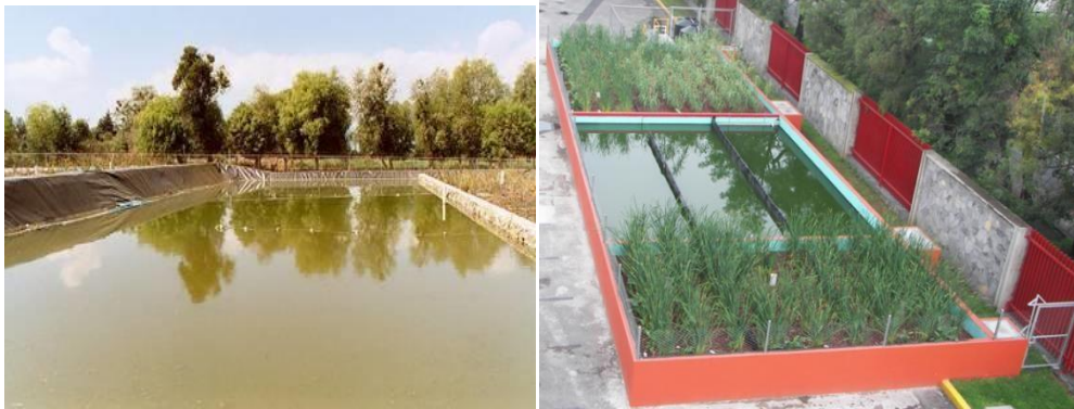
Figura 4.3. a) Ejemplo de lagunas de maduración b) Laguna de maduración de la UAM-A
