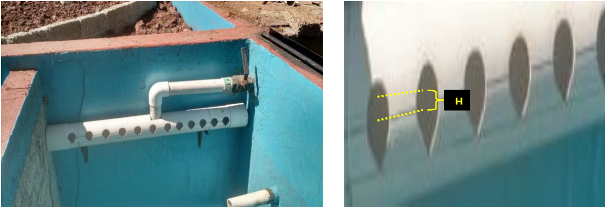
Figura 5.17. Vertedero en el sistema lagunar
