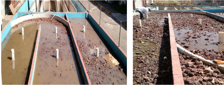
Figura 6.37. Llenado del Sistema Humedal
