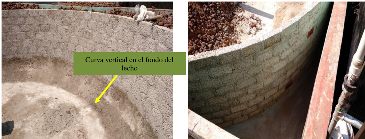
Figura 6.31. a) Vista de la curva vertical en un canal del humedal b). Vista lateral de la curva
