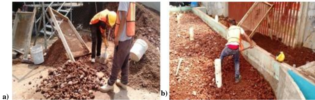
Figura 6.33. a) Limpieza del material .b) Clasificación de acuerdo a su granulometría.
