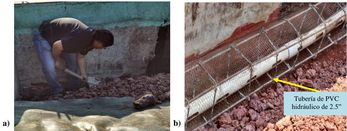
Figura 6.35. a) Limpieza del área. b) Protección de la tubería de dren
