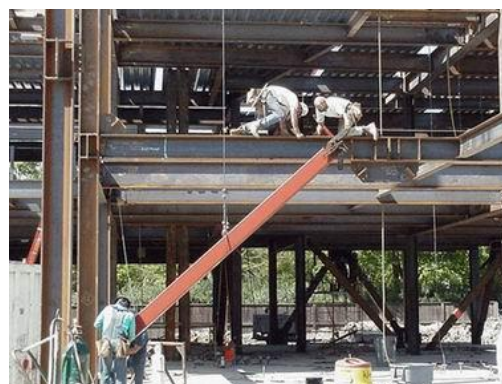
Figura 1.8 Disipador metálico tipo contraviento restringido contra pandeo. http://sirve.cl
