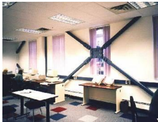
Figura 1.10 Disipador por fricción tipo PALL. http://sirve.cl
