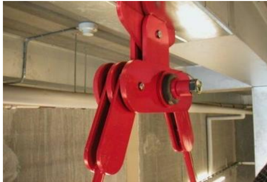
Figura 1.12 Disipador por fricción tipo Golillas. http://sirve.cl
