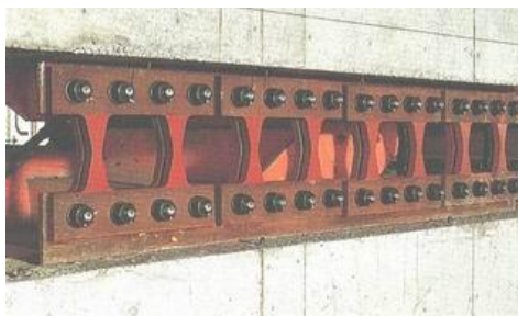
Figura 1.7 Disipador metálico tipo Honey-Comb. http://sirve.cl
