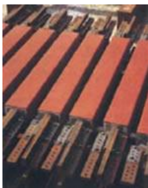
Figura 1.8 Disipador metálico tipo contraviento restringido contra pandeo. http://sirve.cl
