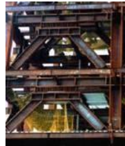
Figura 1.5 Disipador metálico tipo ADAS. http://sirve.cl
