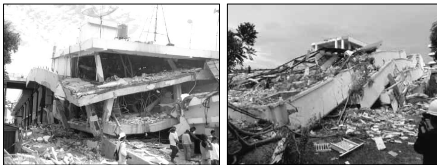
Gambar 1.2. Kerusakan dan Kehancuran Bangunan Setelah Peristiwa Gempa Padang 30 September 2009 (EERI Special Earthquake Report Desember, 2009)
