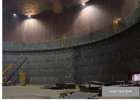
Fig 1- 1: LNG tank, shell erection process.
