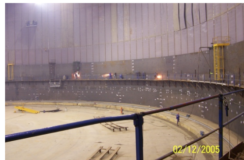
Fig A- 5: Soldeo de juntas horizontales.
