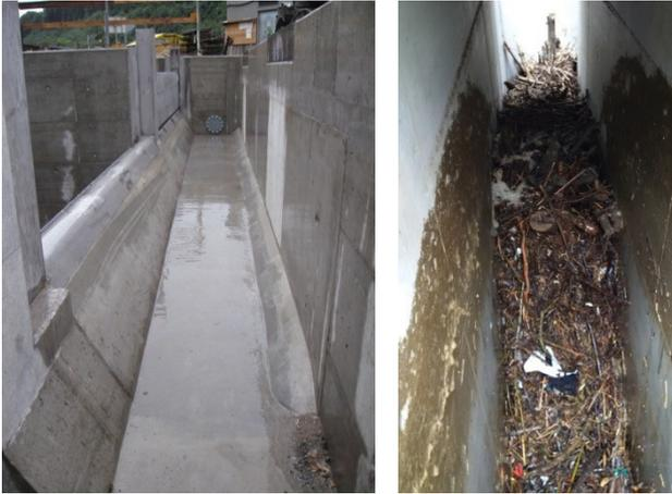
Abb. 17: Links Sammelrinne nach Fertigstellung am WKW Esslingen mit Möglichkeit zur Installation einer Spülpumpe (Rohrleitung mit Blindflansch am hinten liegenden Ende der Spülrinne). Rechts verstopfte Sammelrinne mit Ästen und Müll am WKW Künzelsau.
