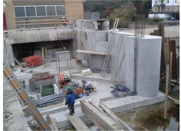
Abb. 94: Verlängerung des Mittelpfeilers am WKW Künzelsau zum Einbau eines Schrägrechens mit Anströmwinkel von  $42^\circ$ , Anströmgeschwindigkeit von  $0,8 \text{ m/s}$  und einem Stababstand von  $15 \text{ mm}$ . Links während des Baus mit Systemschalung für Pfeilerverlängerung und rechts im ausgeschalteten Zustand sowie mit fertiger Sohnische zum Einbau des Schrägrechens.
