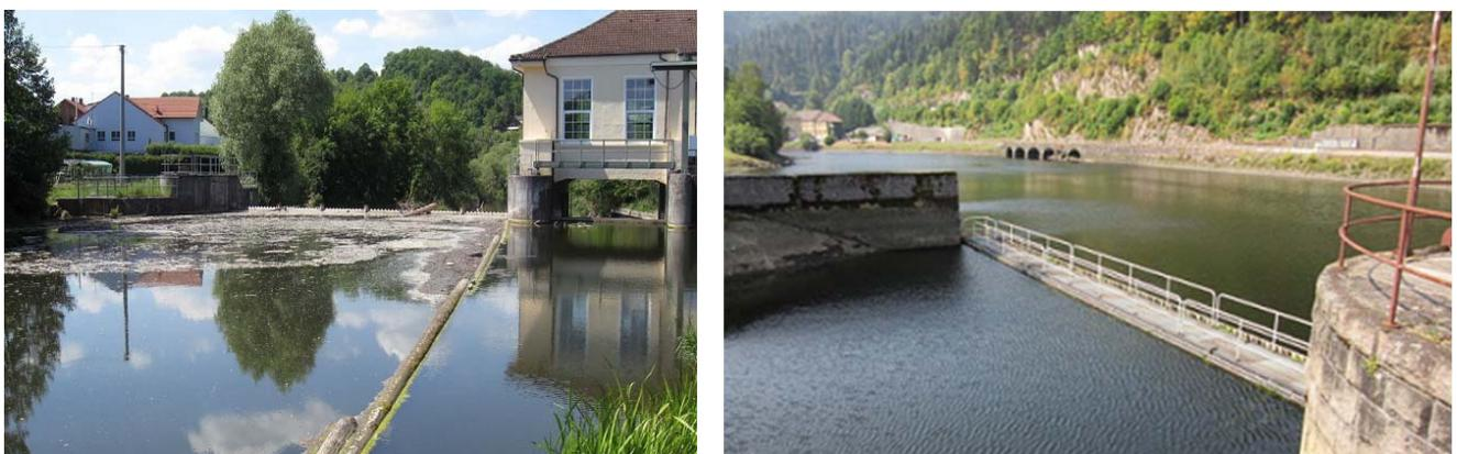
Abb. 6: Geschwemmselbalken aus Holz am WKW Siglingen (links) und begehbarer und höhenverstellbarer Stahlgeschwemmselbalken am Niederdruckwerk Forbach (rechts).
