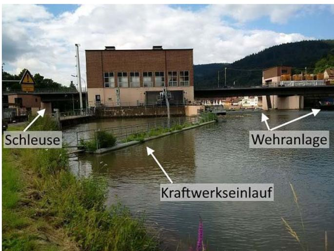
Abb. 93: WKW Hirschhorn mit seiner Lage zwischen der Wehranlage und der rechten Schleusenkammer des Wasser- und Schiffsamtes ohne Möglichkeit zur Vergrößerung des Querschnitts vor den Maschineneinläufen.
