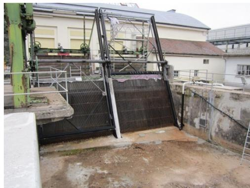
Abb. 14: Links Vertikalrechenquerschnitt mit dem zur Sohle geneigten Winkel  $\alpha$  (*Quelle: verändert nach Giesecke, 2009*). Rechts Foto des Vertikalstabrechens am WKW Ottenau vor den beiden Maschineneinläufen.
