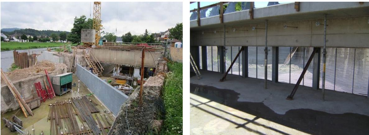
Abb. 8: Schrägrechen am WKW Ottenau mit 44°-Anströmwinkel und 18 mm Stababstand während der Bauzeit in Blickrichtung Unterwasser (links) und in Blickrichtung Oberwasser (rechts) (Quelle: EnBW, 2012).
