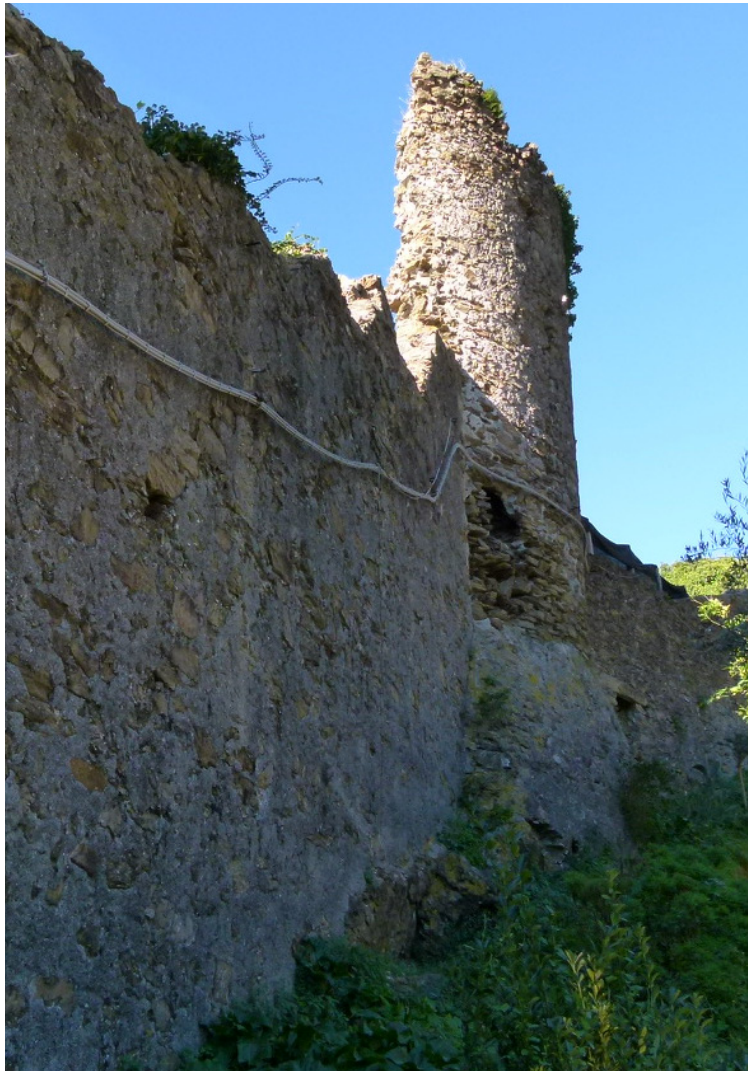
Fig. 3. La torre di Vernazza e le mura (vista da est).
