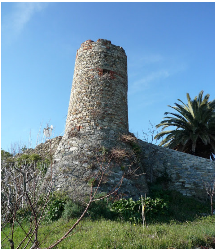
Fig. 1. La "torre rotonda" di Monterosso: vista della parte scudata, con la scarpa aggiunta successivamente.
