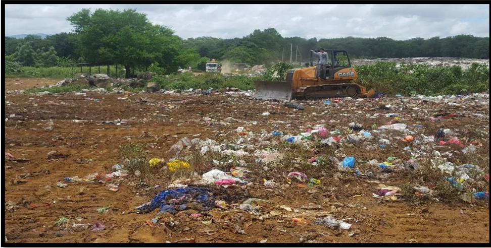
Fotografía 13 Tractor de oruga para soterramiento
