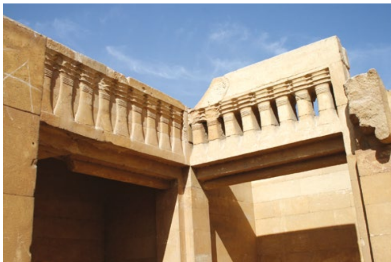
27c. kép. A kápolnák által körbefogott központi termet a kápolnák alacsonyabb teteje felett nyitott, dzsed -oszlopokkal tagolt ablakok világítják meg két oldalról, míg a másik kettőn ennek „vak” változatát faragták ki. Óbirodalom, III. dinasztia, Dzsószer/Netjerihet uralkodása (Kr. e. 2667–2648). Alsó-Egyiptom, Memphisz, Szakkara
