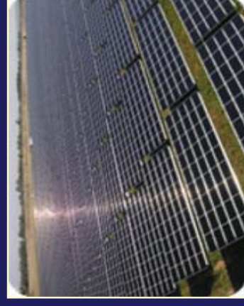
CdTe PV modules (First Solar Inc.)
