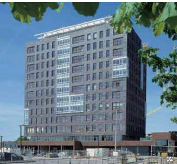
01, 02. De Enk building, Netherlands, 2006. A sinistra: l'edificio per uffici del 1956 prima della conversione, a destra l'edificio dopo la conversione residenziale in 69 appartamenti di tipo economico.
