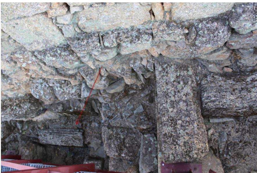
Figura 24 – Interior da muralha romana de Idanha a Velha. É visível o reaproveitamento de partes de um edifício na construção da muralha.
