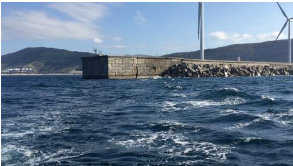
Figura 5-12 Quebramar do Porto de Bilbao
