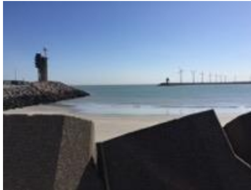
Figura 5-1 Quebra-mar do Porto de Zeebrugge
