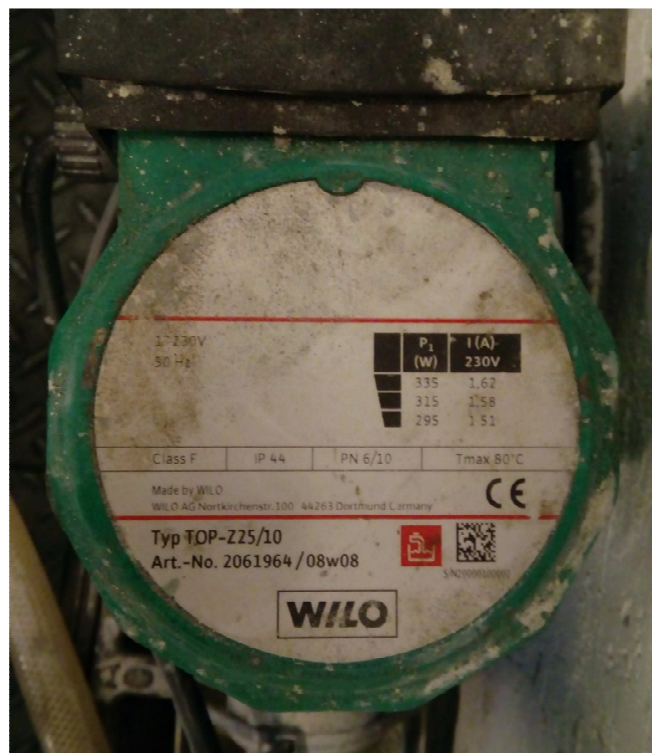
Figura 3.6- Bomba da Wilo para o sistema de arrefecimento.
