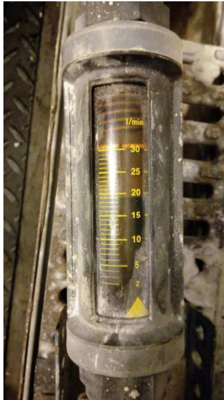
Figura 3.7- Caudalímetro do circuito de arrefecimento.
