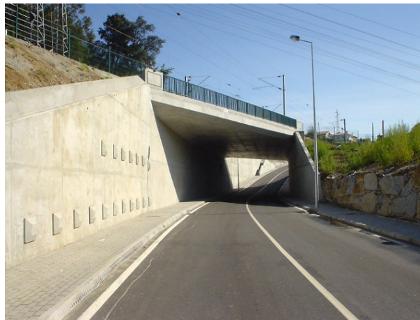
Fig. 5.3 – Passagem Inferior Rodoviária
