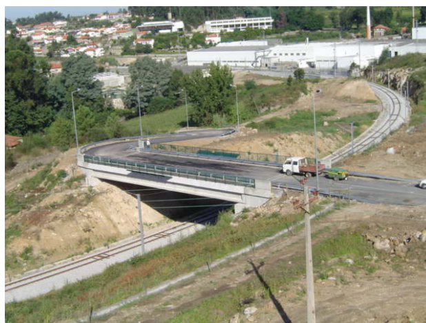
Fig. 5.4 – Passagem Superior Rodoviária
