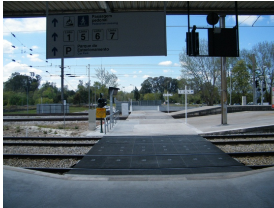
Fig. 3.17 – Automatização de ATV na estação de Coimbra-B
