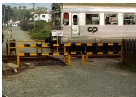
Fig. 3.1. – PN de Peões com labirinto
