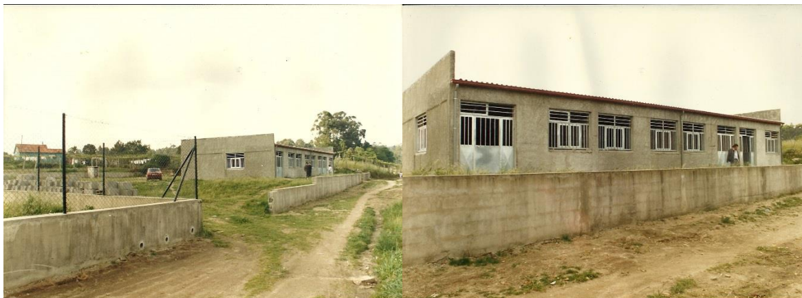
Figuras 6 e 7 – Obra da nova sede
