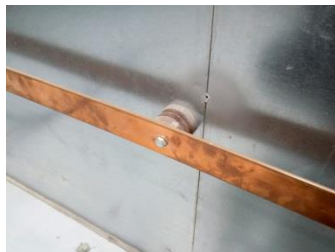
Figura 6.11 - Fixação do barramento principal à parede do LAT
