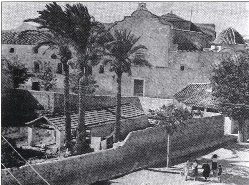
Lámina 1: Vistas del frontal del complejo conventual.
