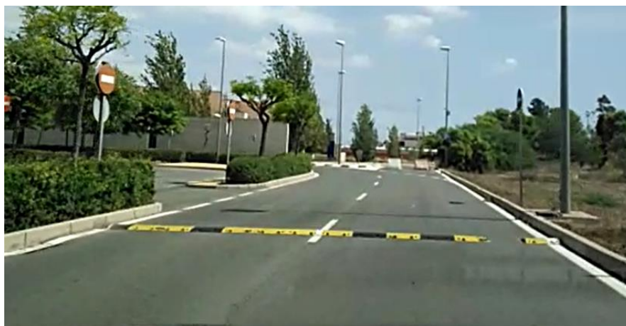
Figura 105. Reductor de velocidad antes de curva 4.1. Elaboración propia.
