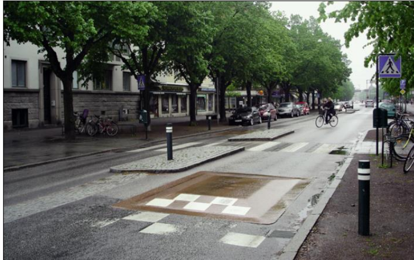
Figura 109. Almohada protegiendo un paso peatonal en Malmo (Suecia). (Fuente: Calmar el tráfico. Ministerio de Fomento).
