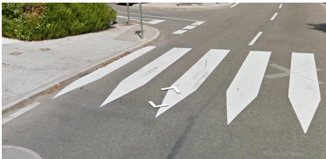
Figura 104. Desnivel entre acera y paso peatonal 15. (Fuente: Google Street View).
