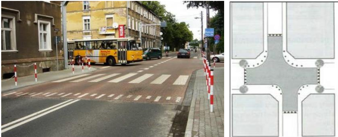
Figura 111. Intersección sobreelevada o realizada. (Fuente: Manual de pacificadores de velocidad en vías urbanas).
