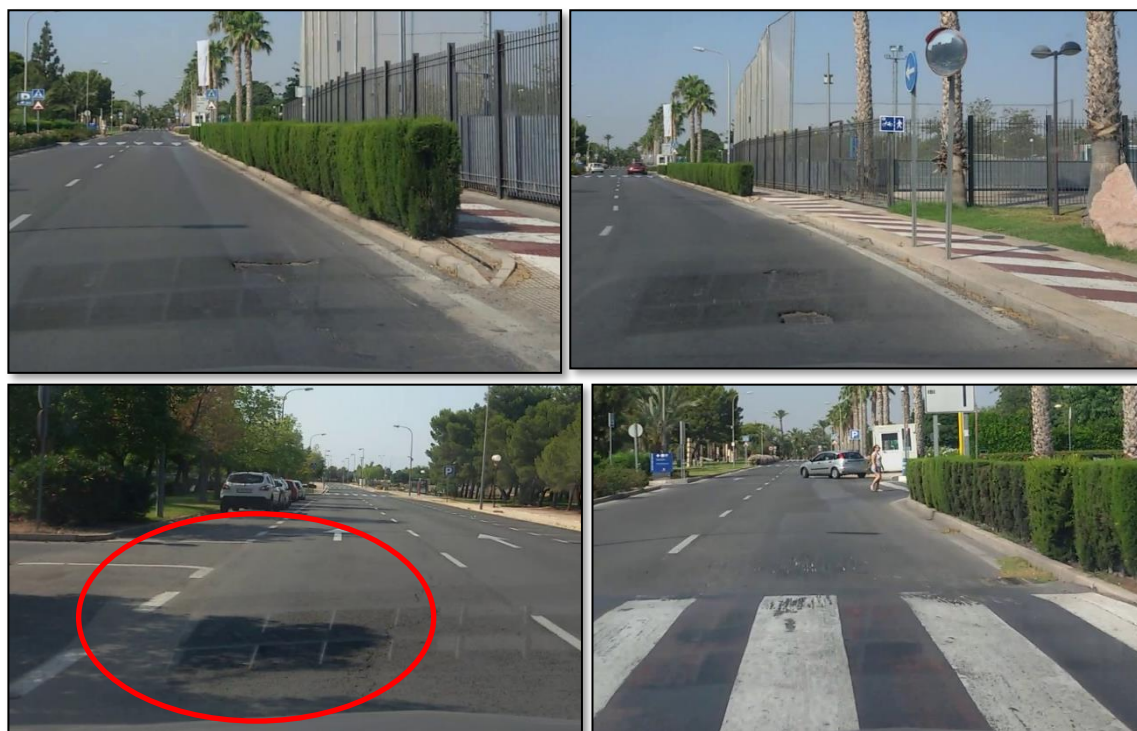
Figura 59. Deficiencias del firme en el campus de la UA. Elaboración propia.
