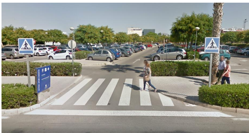
Figura 35. Acceso del Aparcamiento frente a la Facultad de Ciencias VI. (Fuente: Google Earth).
