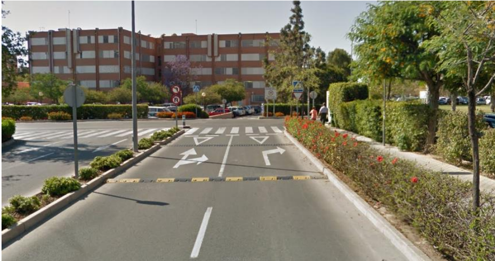
Figura 92. Reductor de velocidad en Entrada Norte. (Fuente: Google Maps).
